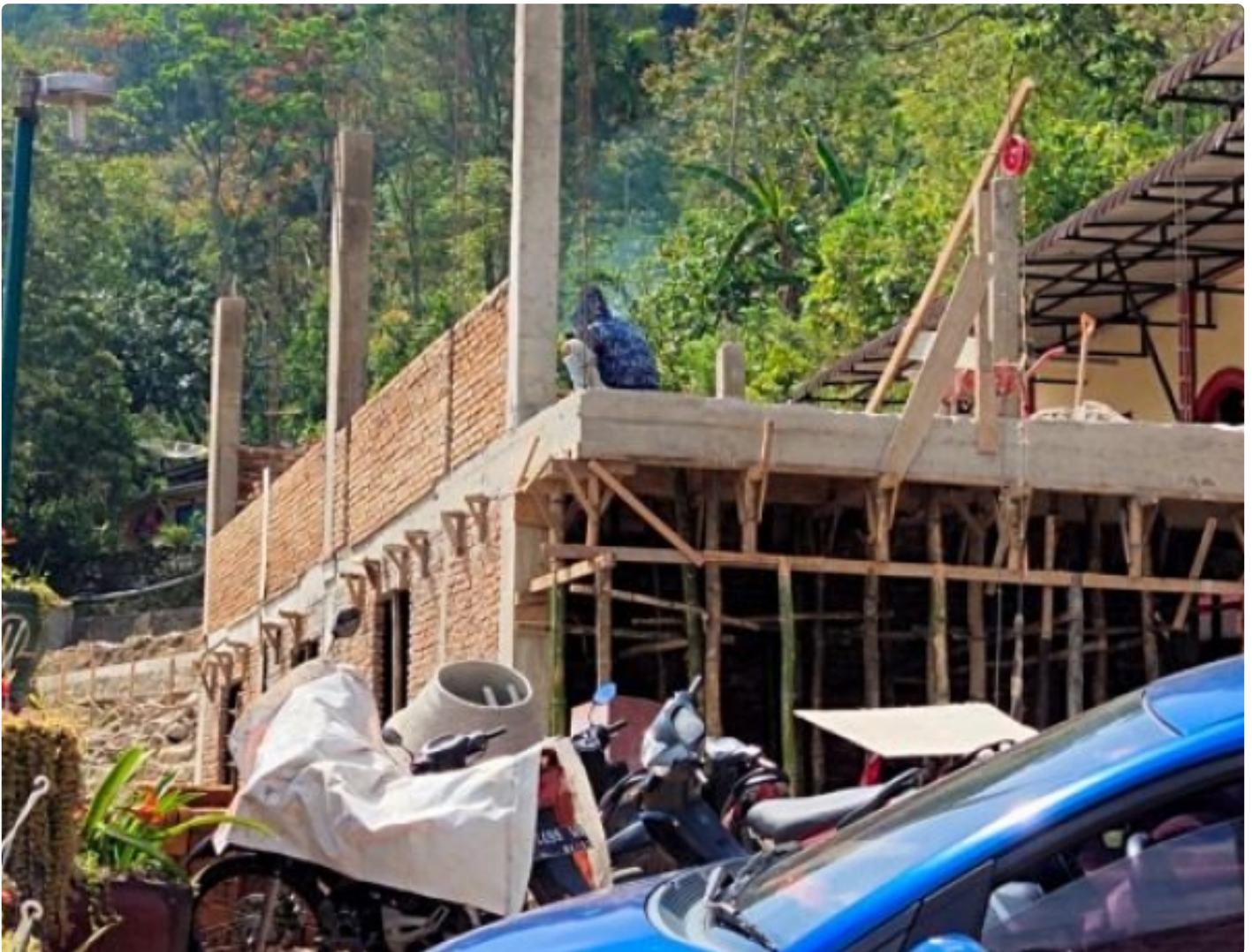
Bangunan Hotel Sedayu di Jalan Bangun Dolok
